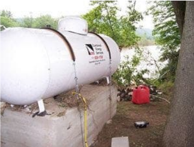
Ancoraggio di una cisterna in area alluvionale
